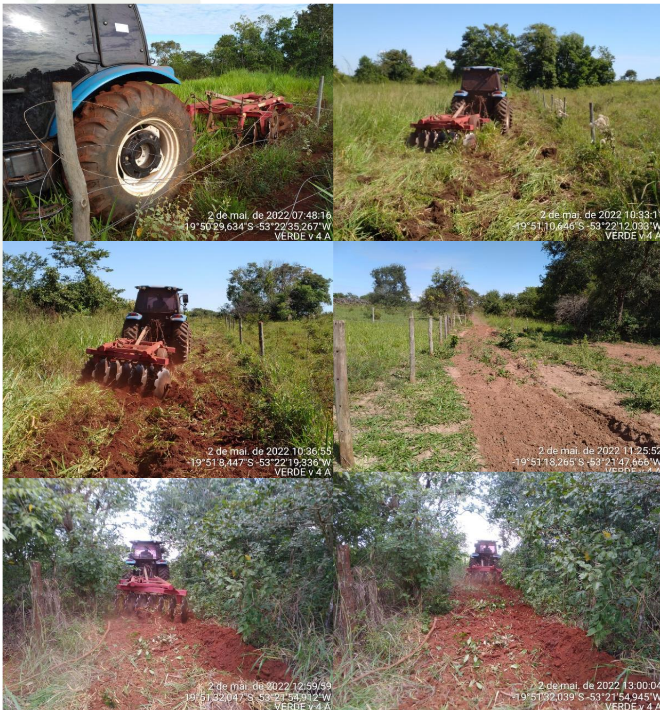
Figura 8. Execução da atividade de construção de aceiros.
