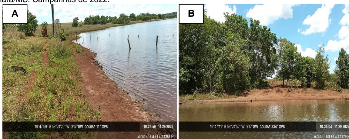
Figura 17 – Pontos 15 (A) e 16 (B): Erosões laminares, área 1 da PCH Verde 4A, no município de Água Clara/MS. Campanhas de 2022.
