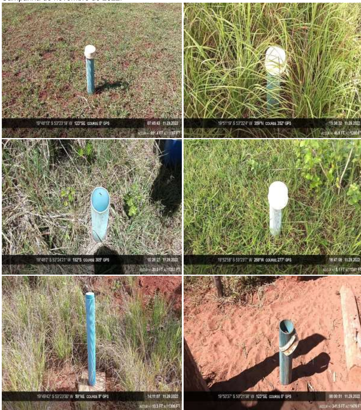
Figura 1 - Poços de monitoramento da PCH Verde 4A. Pontos de cima para baixo: P1 a P6. Campanha de novembro de 2022.
