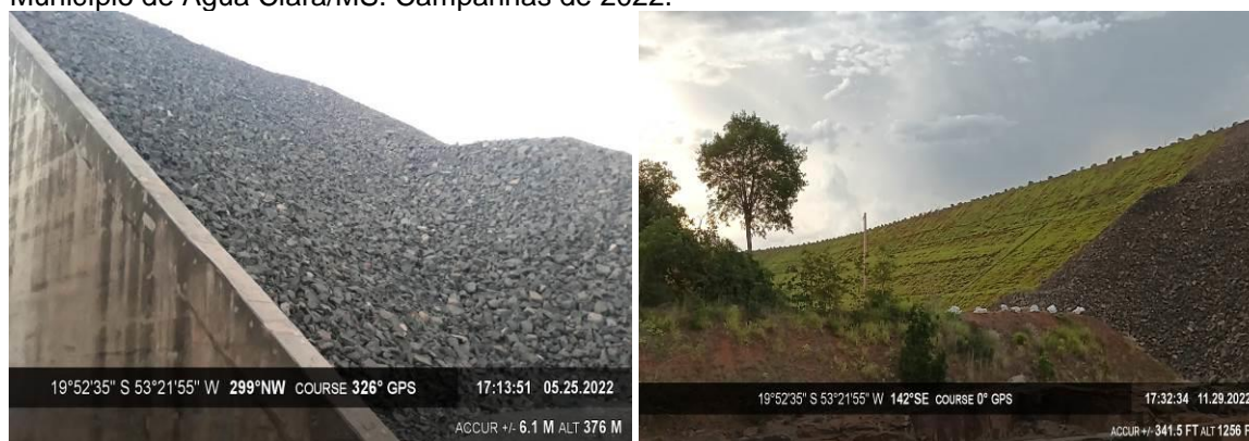
Figura 22 – Talude de contenção da PCH Verde 4A, evidenciando área cascalhada e gramada. Município de Água Clara/MS. Campanhas de 2022.
