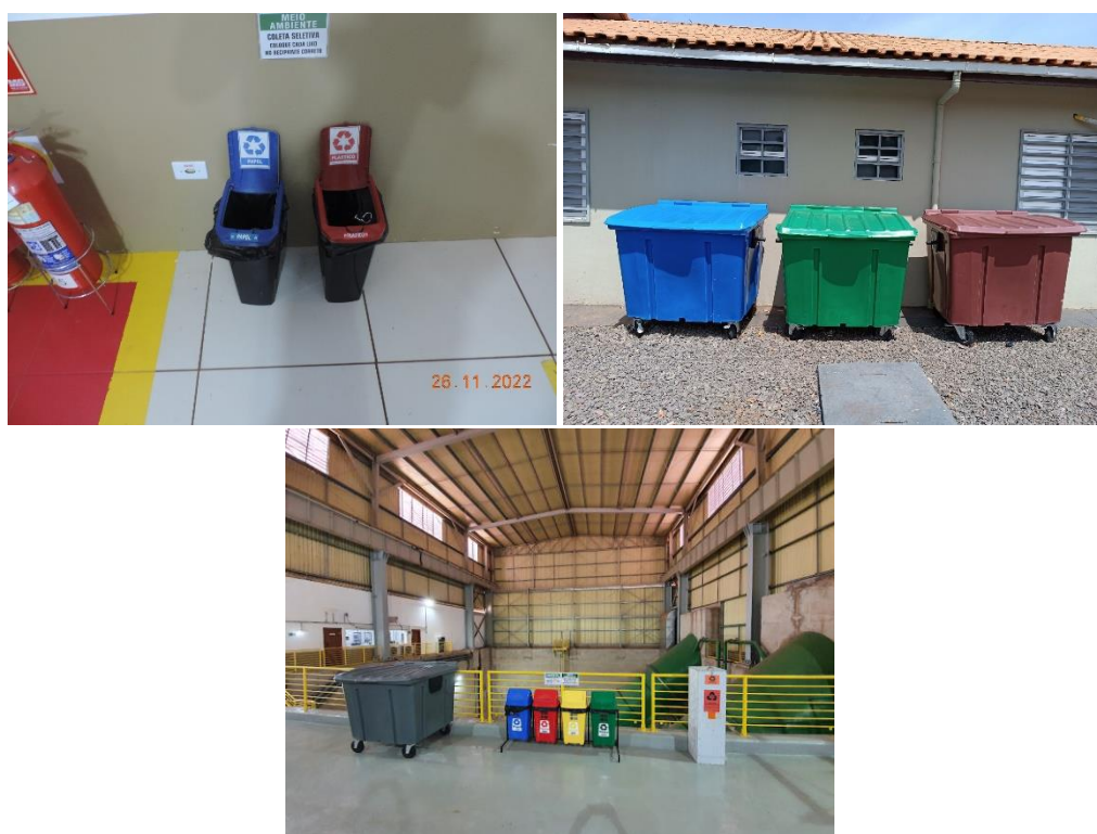
Figura 1. Recipientes para coleta seletiva nas áreas interna e externa da casa de força. Foto: Cedro Inteligência Ambiental.
